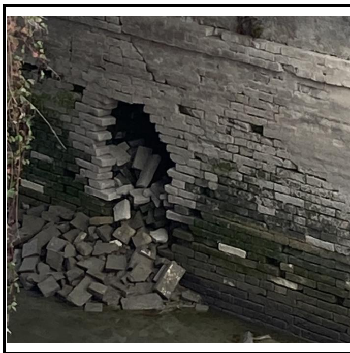
Figura 7-1 Foro muratura spalla nord
