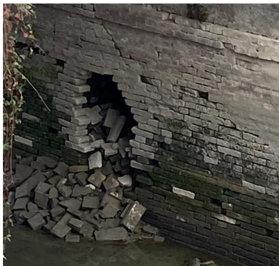
Figura 9-1 Foro spalla Nord
