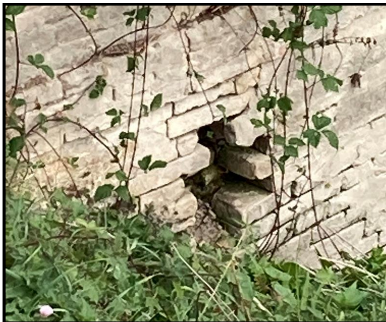
Figura 7-2 Foro presente sul muro d'ala
