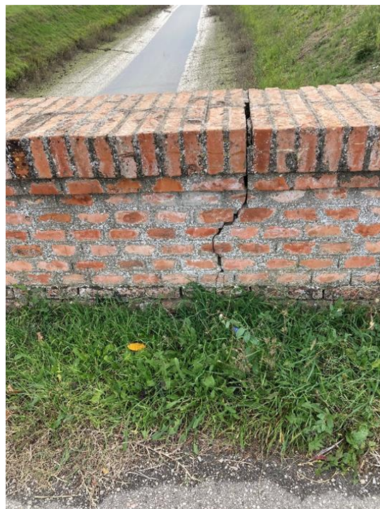
Figura 9-2 Lesioni del parapetto
