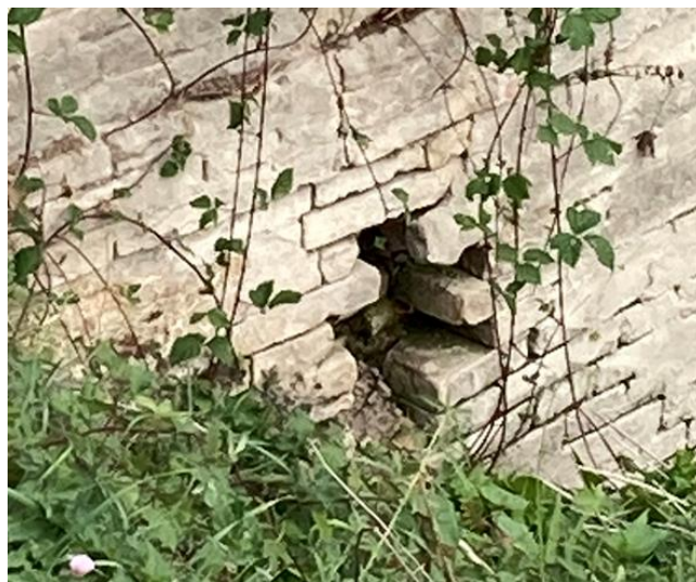
Figura 9-2 Foro presente sul muro d'ala
