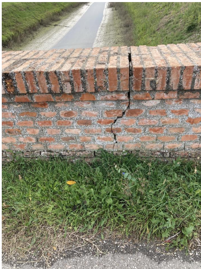
Figura 7-6 Lesioni del parapetto
